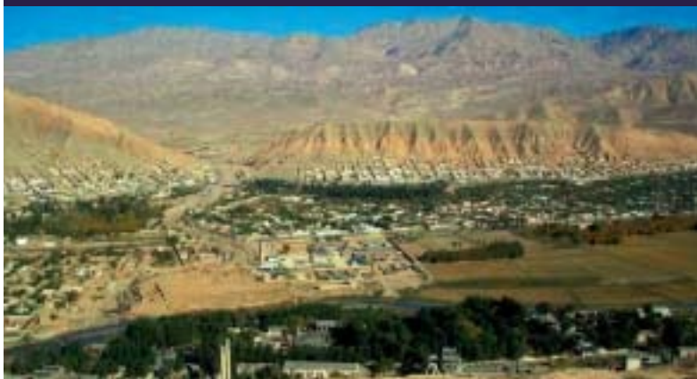
Zicht op Pol-e Khomri met in het midden het Nederlandse kamp in aanbouw
