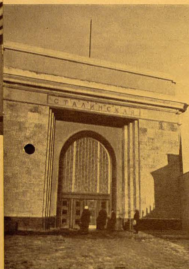
Bovengrondse deel van de halte „Stalin“
